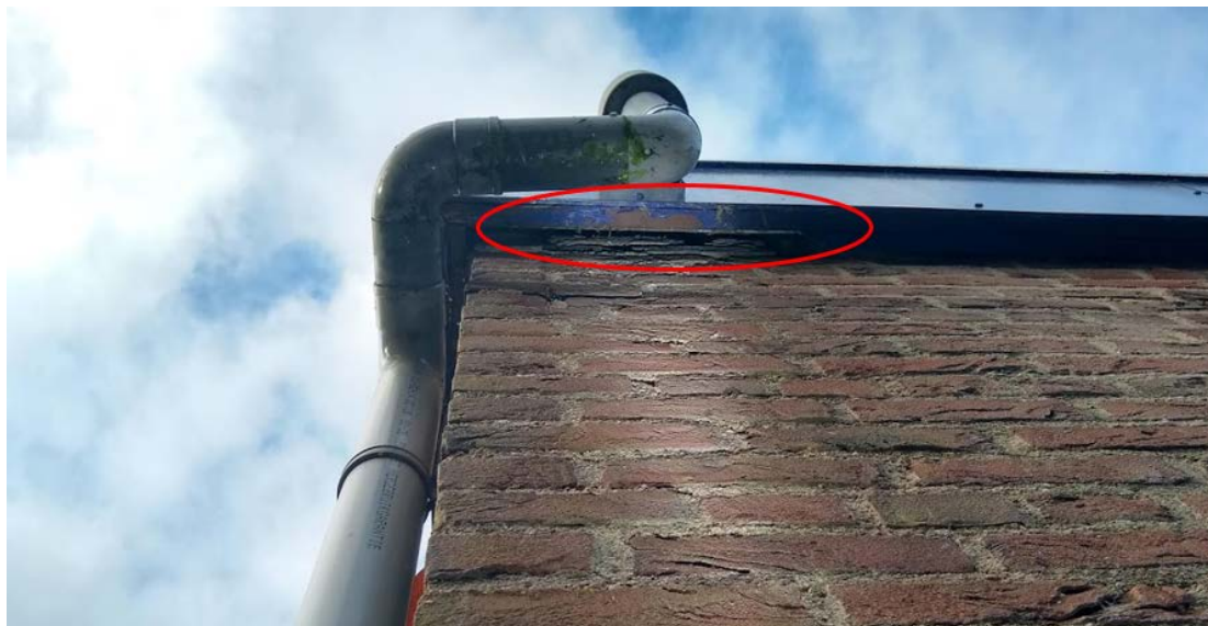
Figuur 3.2: Opening onder de daklijst die toegang biedt tot een ruimte onder het dak of achter de daklijst.
