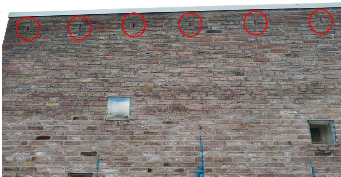
Figuur 3.1: Open stootvoegen (rode cirkels) die toegang bieden tot een spouw.
