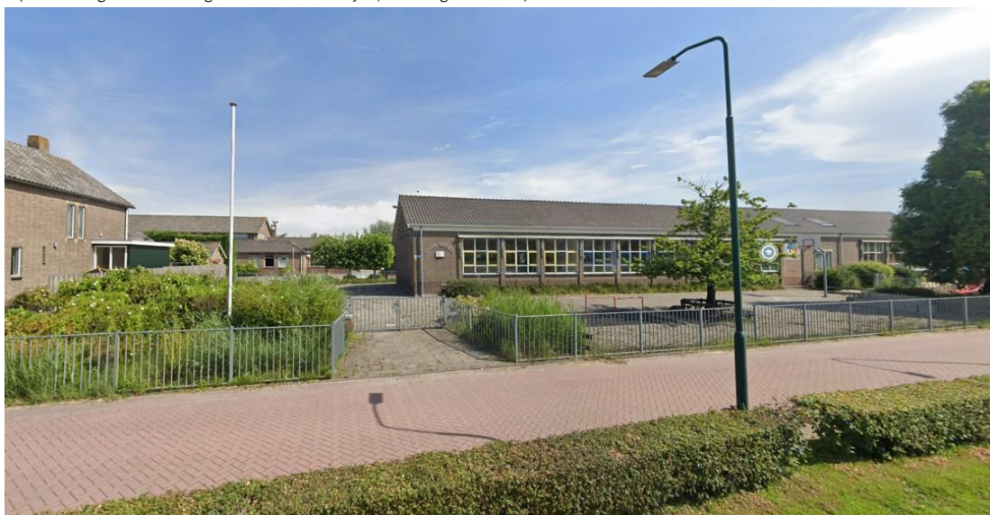
Impressie huidige situatie schoolgebouw vanaf zuidwestzijde (bron: Google streetview)
