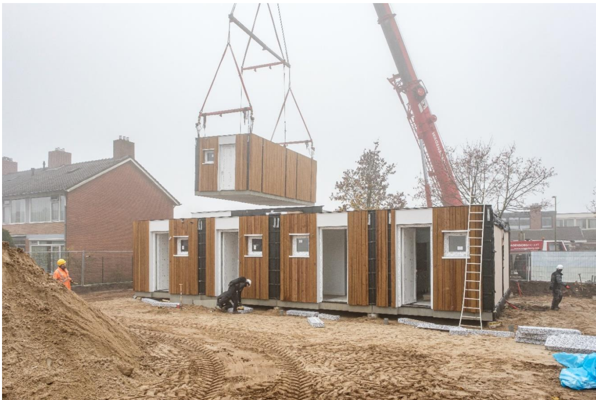
Figuur 11: Project in uitvoering – bron Faro architecten
