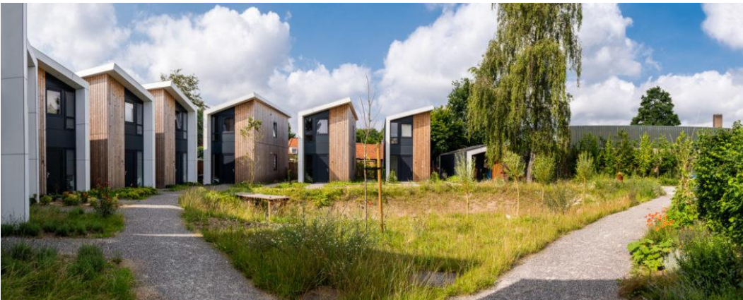
Figuur 5: Impressie flexwoningen – bron Faro architecten
