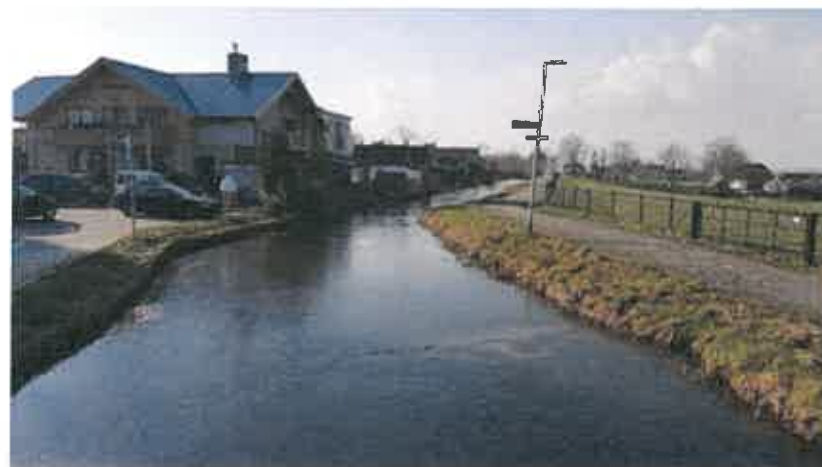
2.2. Ringsloot bovenaan de dijk
